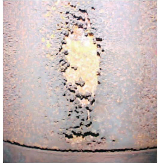
Fig. 6.1.3 Cavitación sin corrosión
